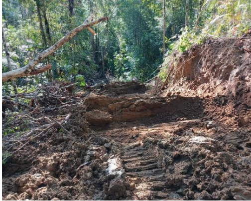
Gambar: Pembuatan Sudetan
