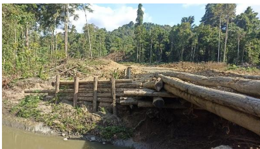
Gambar: Bangunan Konservasi Turap
